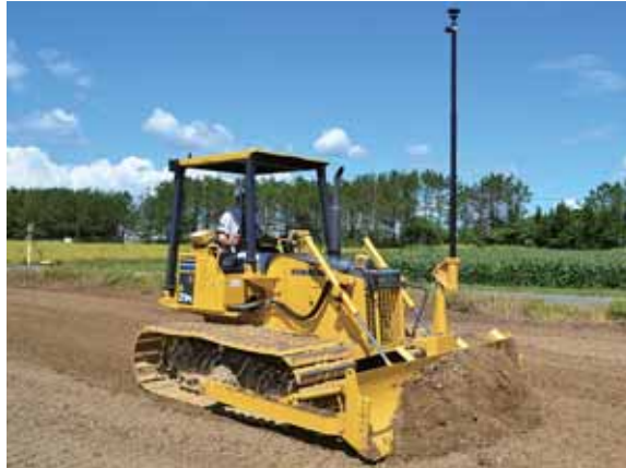
ICTを活用したブルドーザー
