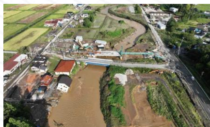
収穫間近の田畑にも大きな被害が発生
