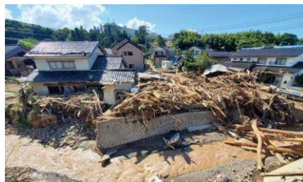
土砂崩れ・流木による被害が多数
