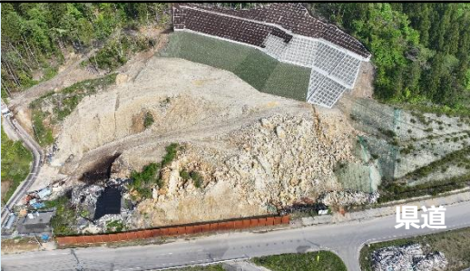
崩壊した斜面を整形し法枠工を施工
