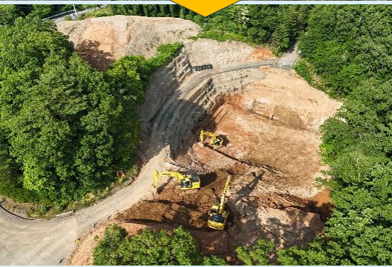
崩壊した斜面を整形し法枠工を施工
