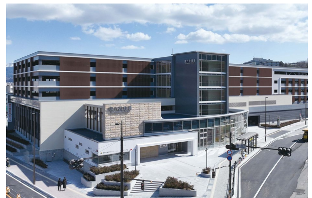
▲ 完成した兼六駐車場
