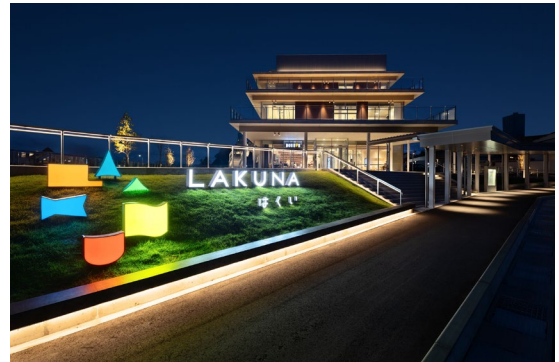
▲ 羽咋市にぎわい交流拠点 LAKUNAはくい
