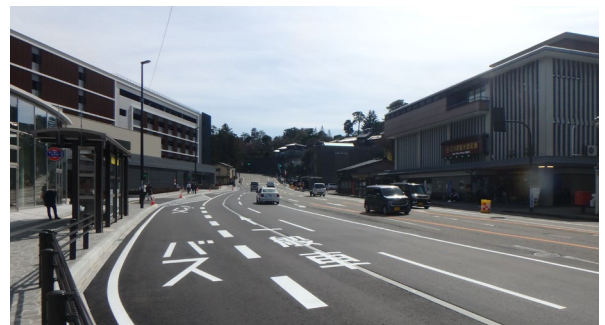
▲ 兼六駐車場への進入レーンの追加
