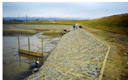
県産の間伐材の木製法枠工で、栗石の隙間から植生が期待（調整池／小松市）
