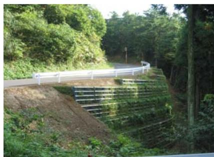
補強土壁工を採用して壁面を緑化し、間伐材により意匠を工夫
