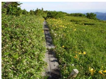
水分条件の変化や、登山者の踏圧による植生破壊を防止するため、木道工法を採用
