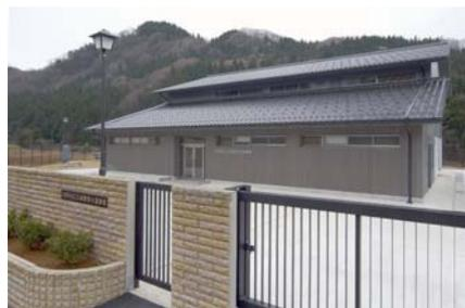
瓦葺きの勾配屋根で、外壁は地元産の能登ヒバを使用し、周囲の集落や樹林との調和に配慮（新町野浄水場／輪島市）
