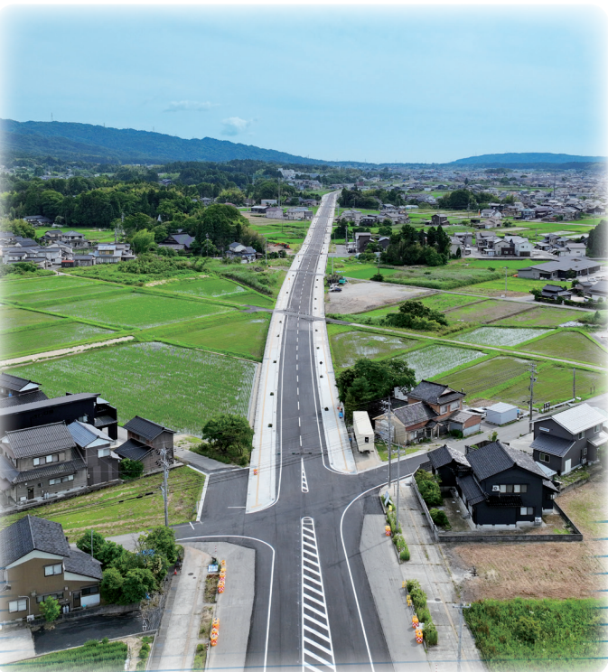
万行町方面から古府町方面を望む(完成)
