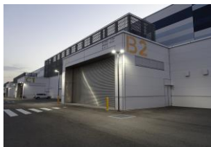
大型の搬入口 (愛知県国際展示場)
