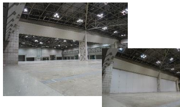
間仕切で分割可能な仕様 (東京ビッグサイト)
