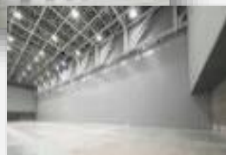
引用 https://www.komatsuwall.co.jp/case/detail/2913 間仕切り（Gメッセ群馬）
