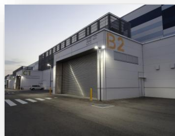
大型の搬入口（愛知県国際展示場）
