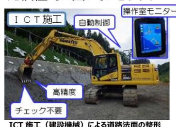
ICT施工（建設機械）による道路法面の整形
