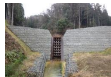
◀ 生態系に配慮した砂防堰堤
