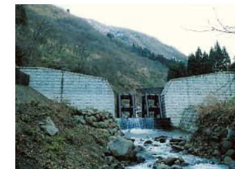
砂防堰堤（白山市）
