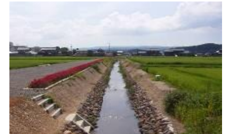
▲自然石による水路整備
