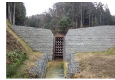
◀ 生態系に配慮した砂防堰堤
