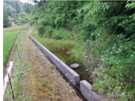
残地を利用したビオトープ
