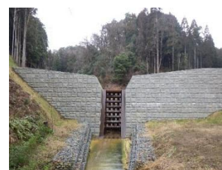
生態系に配慮した砂防堰堤
