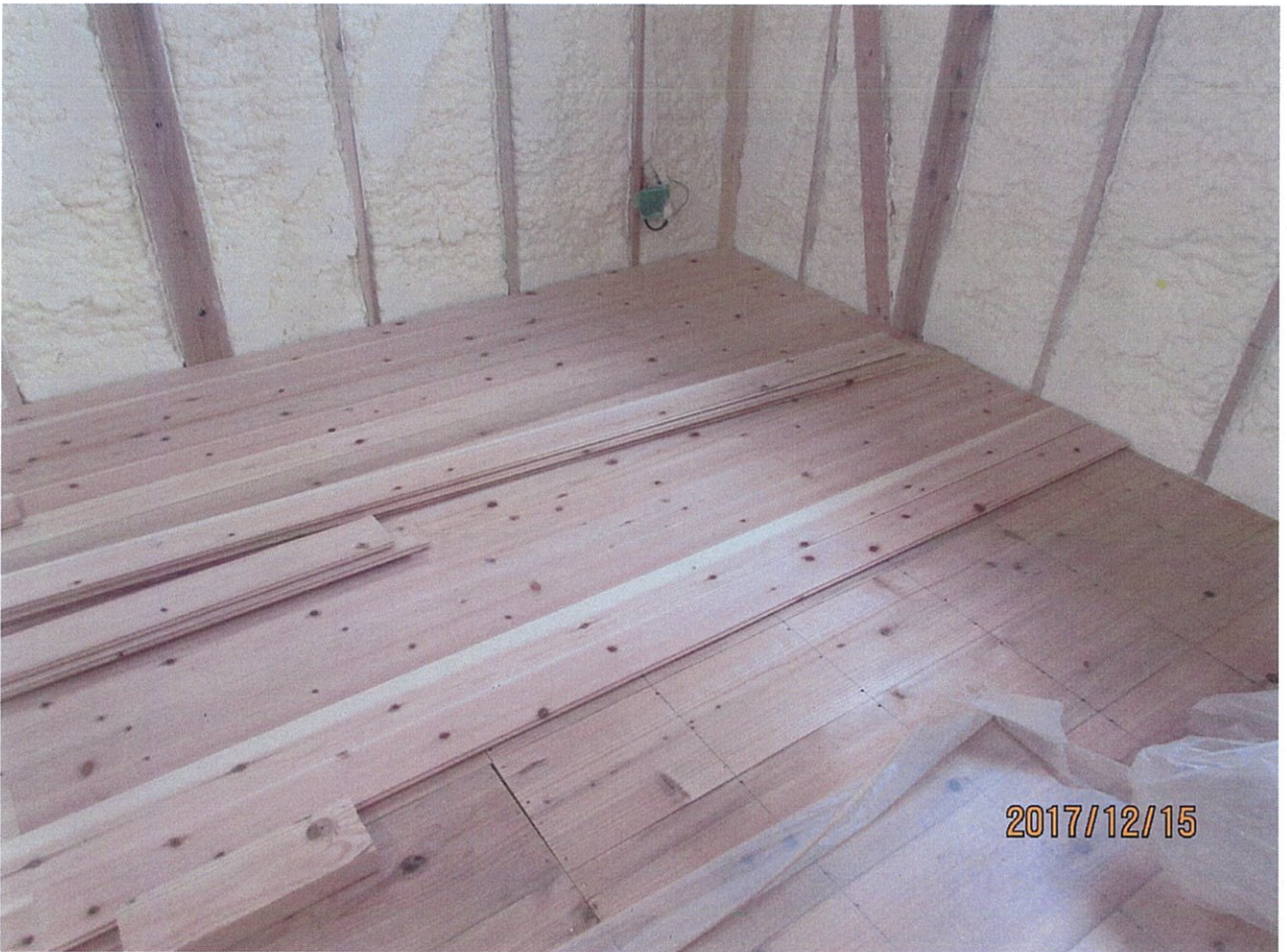
床下地・床仕上げ材
