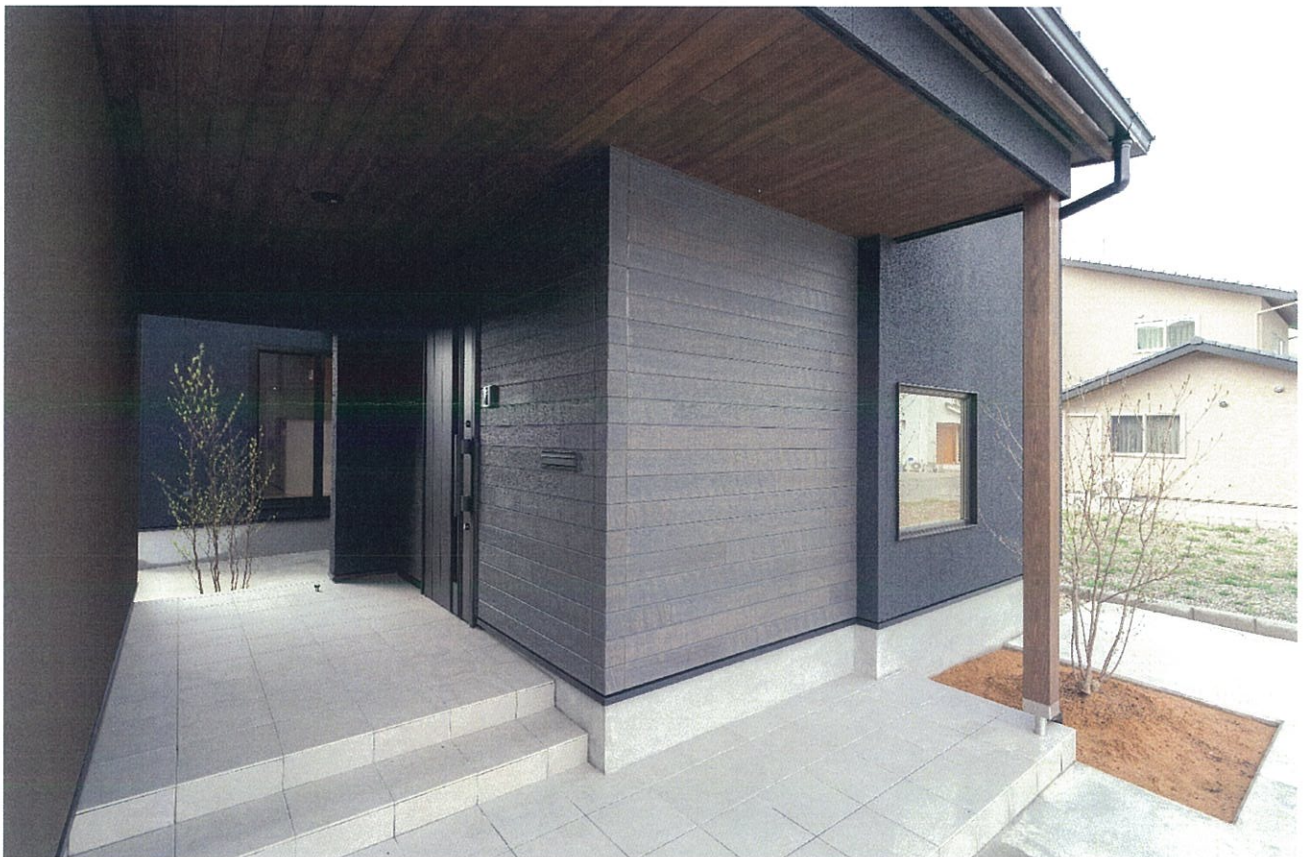
ポーチ天井板張り・ポーチ柱
