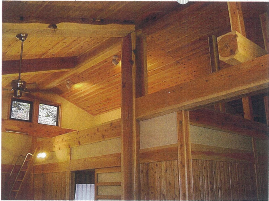
① 大黒柱、柱、梁桁、羽目板
