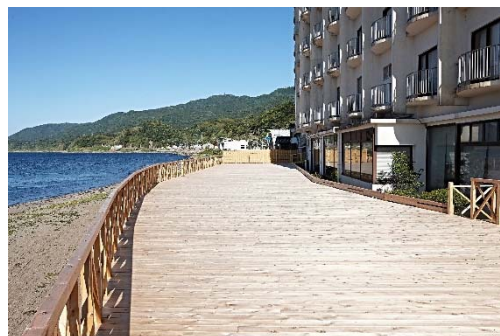
ホテルこうしゅうえん天海シーサイドテラス【輪島市】(設計・施工:山下住宅)
