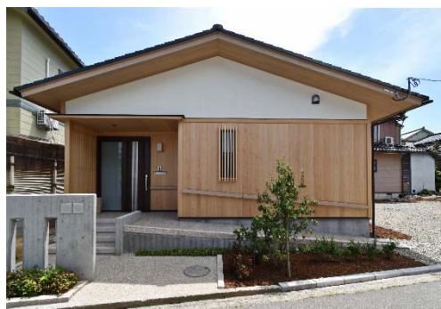
土蔵の面影を残す木の香の家【金沢市】(設計:有限会社風建築設計工房、施工:株式会社棚田建設)
