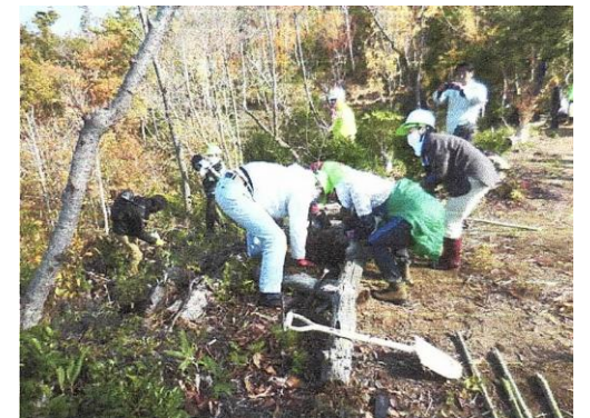
散策路の整備
