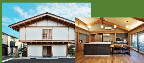
二世帯の大屋根の家（金沢市）
