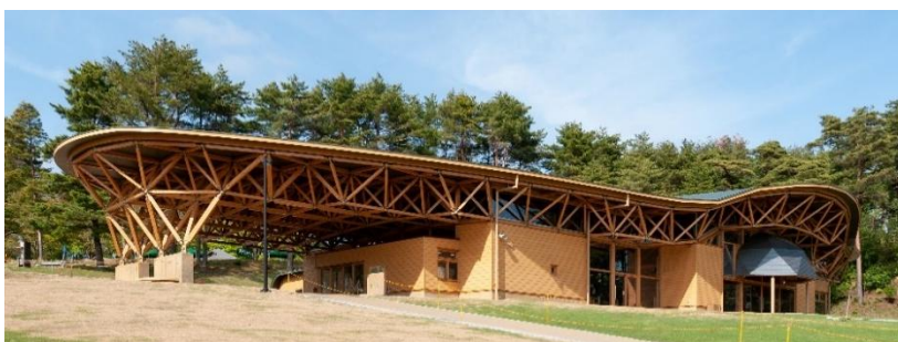
奥卯辰山県民公園のびのび交流館とんぼテラス 外観（金沢市） （能登ヒバ、県産スギ）
