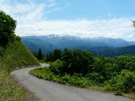
林道の整備（白山市）
