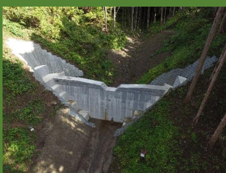
谷止工の完成写真 (中能登町)
