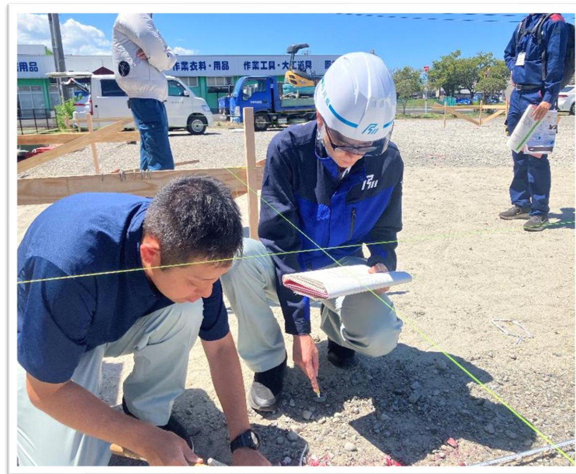
八代市で地縄検査を実施 (建物の予定位置が設計図どおりになっているか現地で確認)
