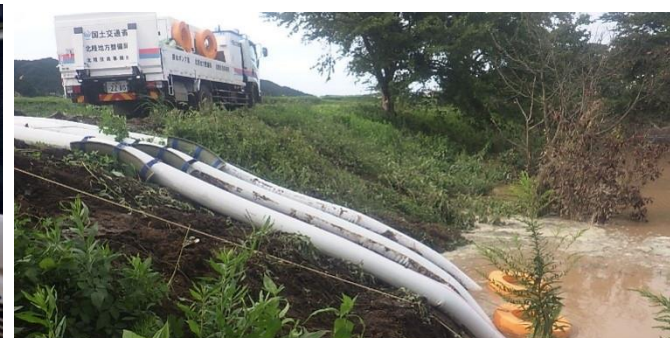
排水ポンプ車派遣（輪島市）
