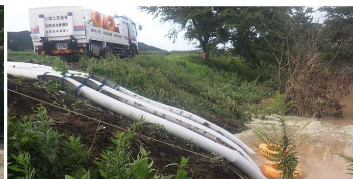
排水ポンプ車派遣（輪島市）
