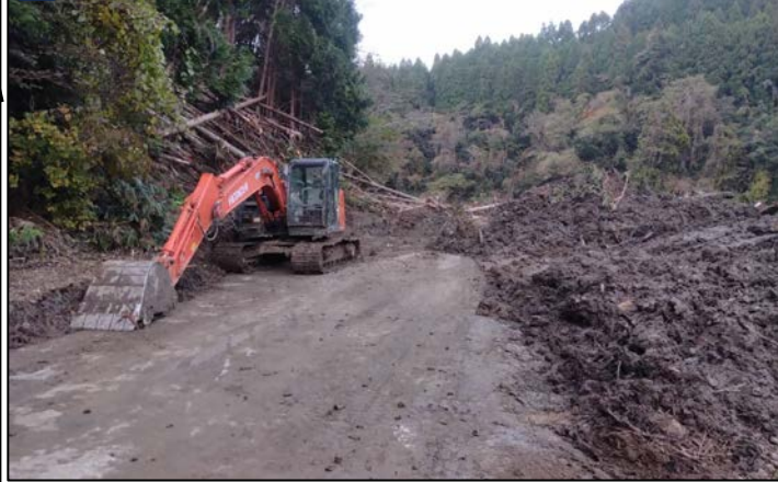
道路啓開状況
