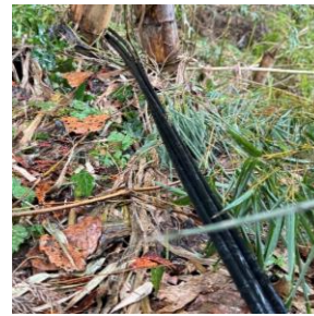
ケーブル網の応急復旧 （地面敷設）
