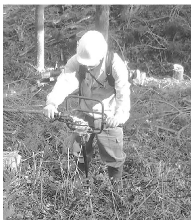
写真-2 植栽機使用状況
