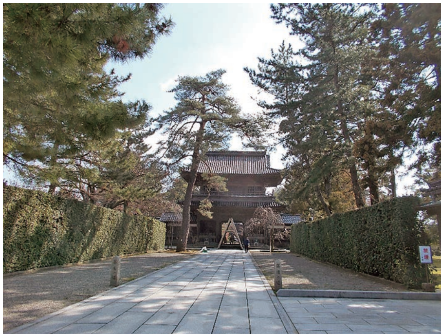
写真-6 金沢市小立野地内 施工前 (2019年2月26日撮影) 変色した葉が目立ち、葉量が少なくなっている
