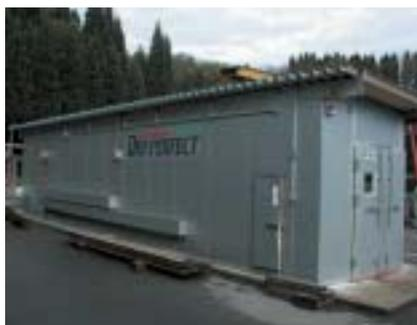
除湿乾燥機は、一般家庭の暖房除湿エアコンが工業的に用いられていると考えればよく、木材が投入されている乾燥室内を加熱（暖房）し、蒸発してくる水分を冷却結露させて除湿して温湿度を制御します。低温で緩やかな条件で乾燥するので、変色が少ないのが特徴です。
