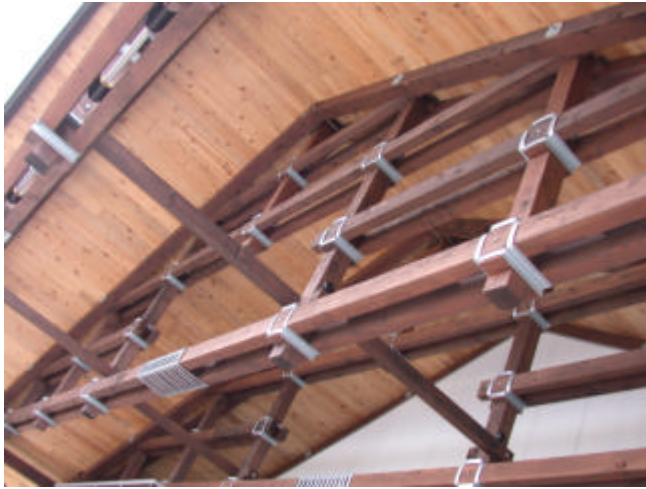
小屋組の様子
