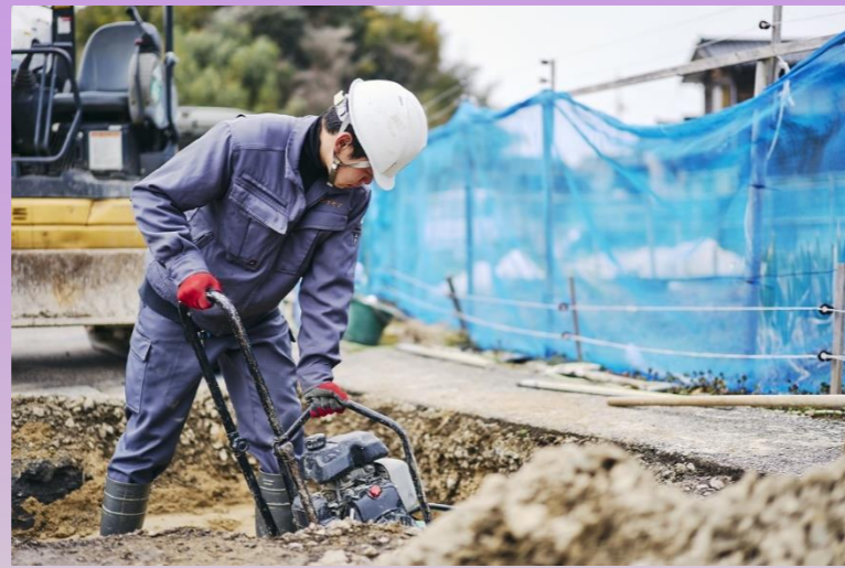
水道復旧工事の様子
