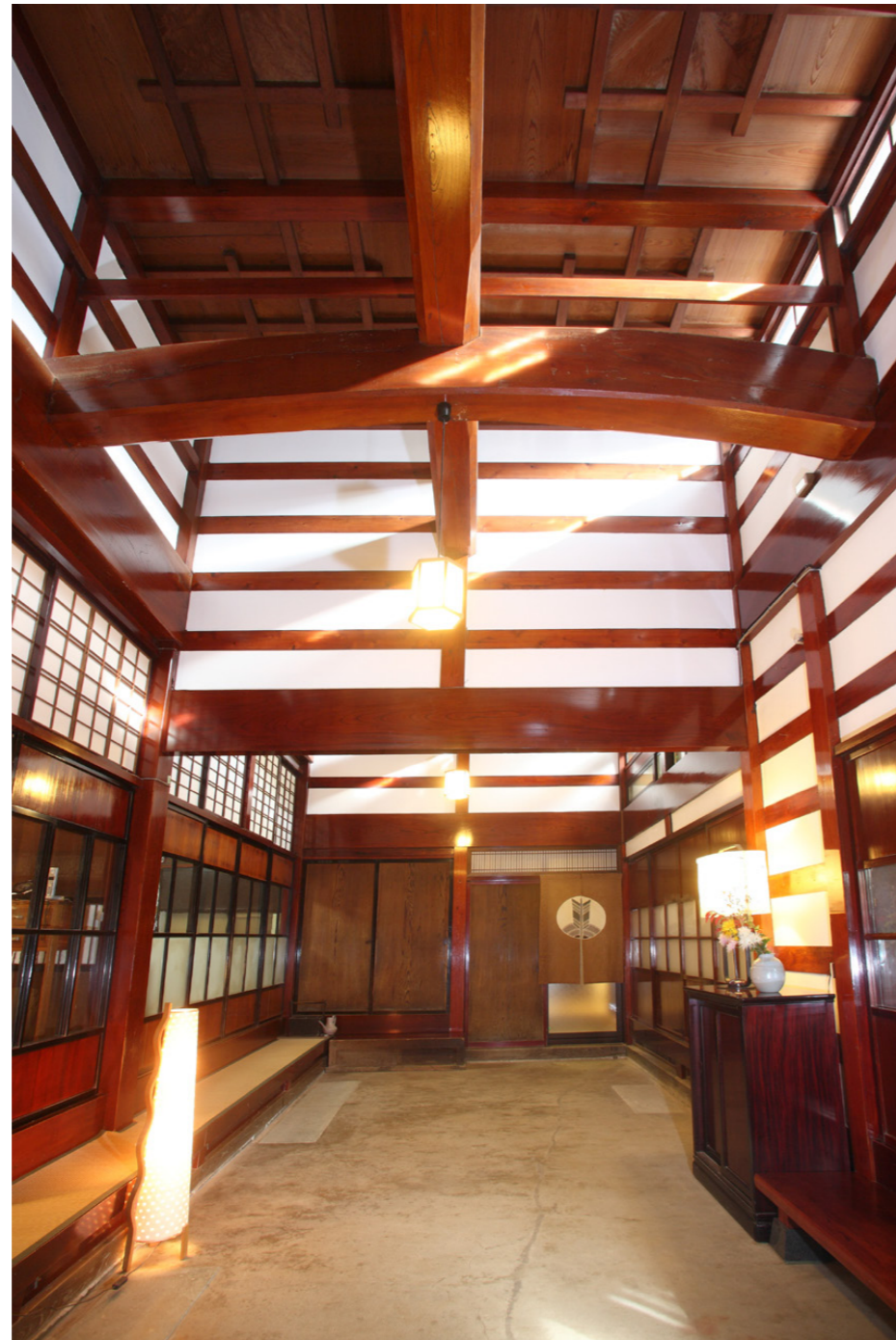
土間空間：上部に明かり窓を配し、明るくした
