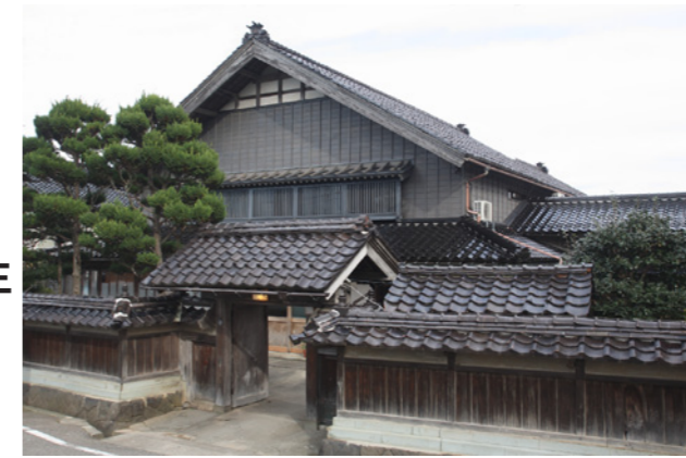
外観：主屋外壁・塀修復後
