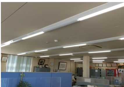
全照明LED化＋点灯箇所最適化
