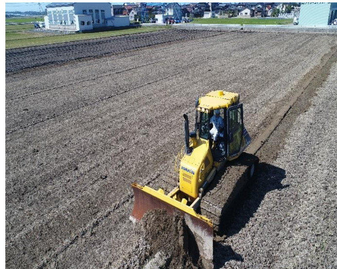
畔畔除去作業状況
