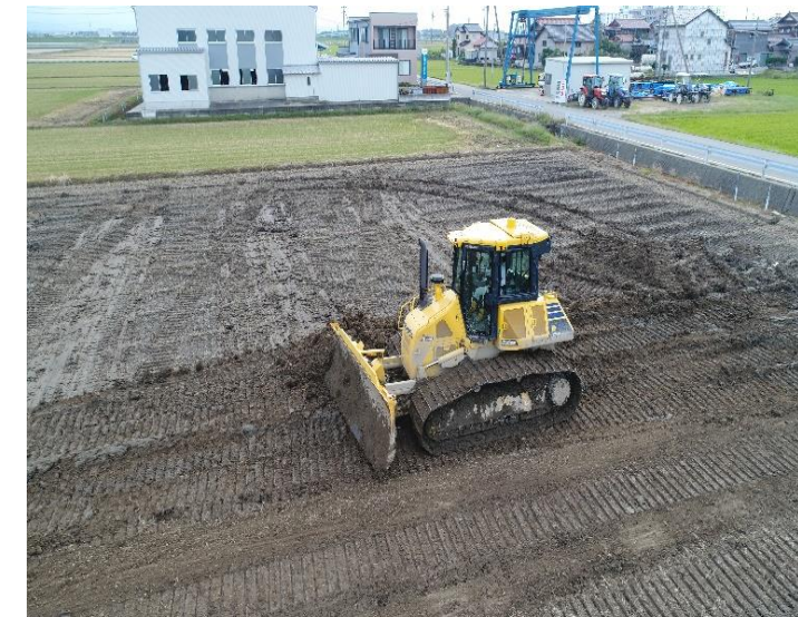
均平化作業状況
