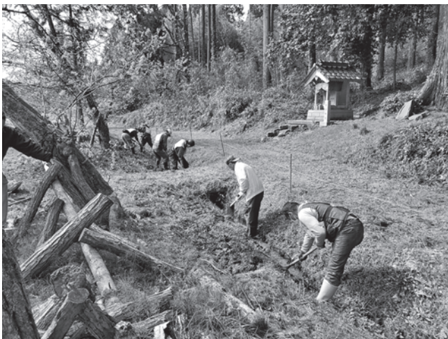
水路の泥上げ
