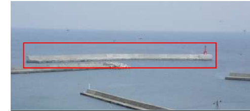
防波堤の整備により、港内の静穏度を確保
