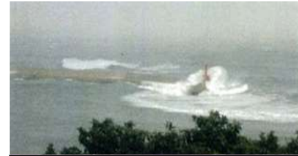
荒天時の治波発生状況
