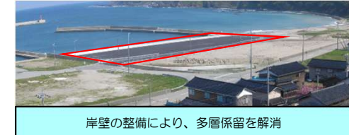
岸壁の整備により、多層係留を解消
