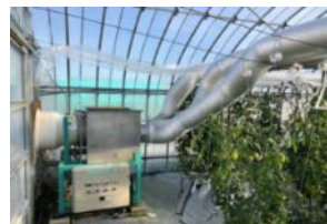
図1 地下水空調装置
