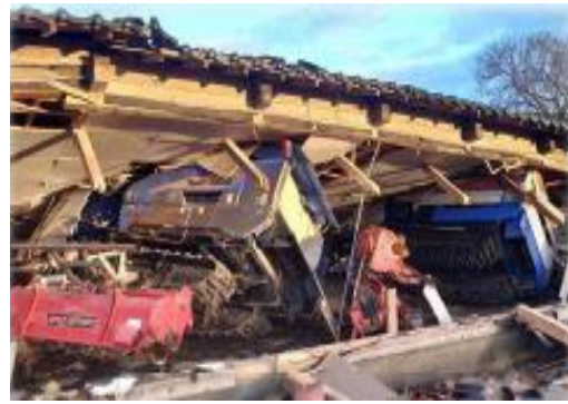
農業機械・納屋損壊(輪島市)
