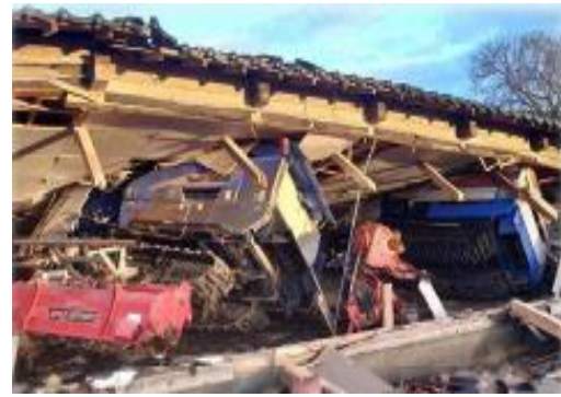
農業機械・納屋損壊(輪島市)
