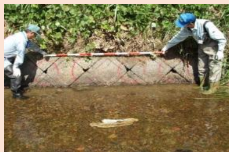
用排水路の点検状況
