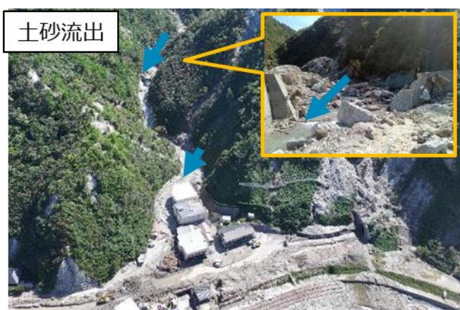
【豪雨】上流部からの土砂流入（珠洲市）
