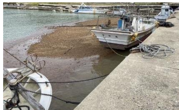
【豪雨】漁港内に土砂堆積（珠洲市）
