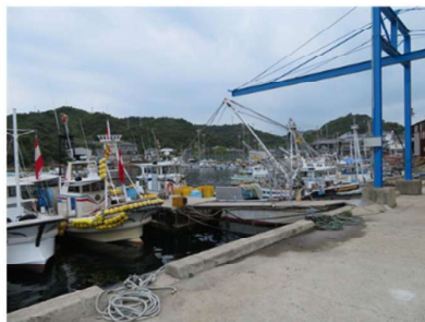
橋形クレーン
