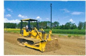
農業用ブルドーザによる均平作業
