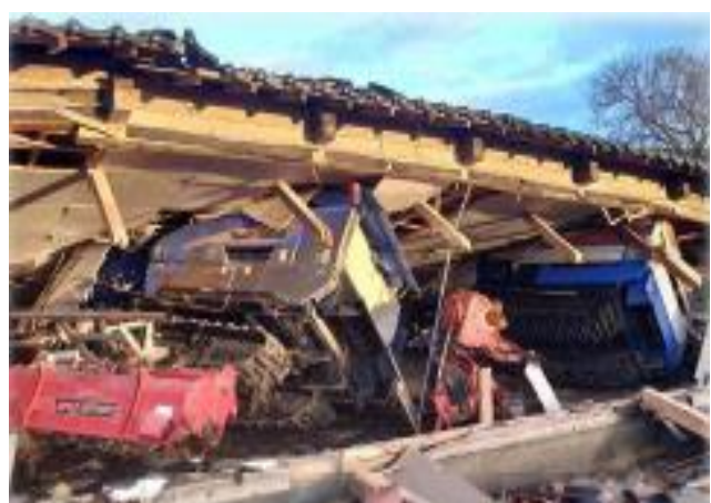
【地震】農業機械・納屋損壊（輪島市）
