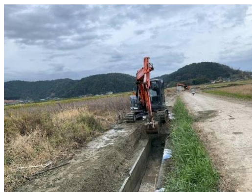
排水路の土砂撤去（輪島市）
