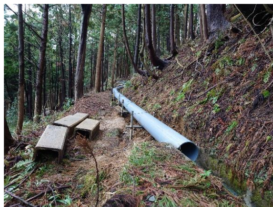
用水路の応急復旧状況
