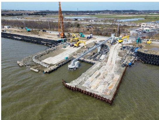
水管橋完成(R8.2 時点)
