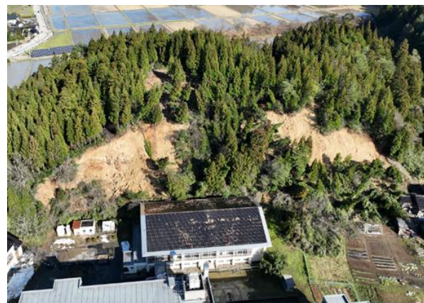
【地震】山腹崩壊（珠洲市）
