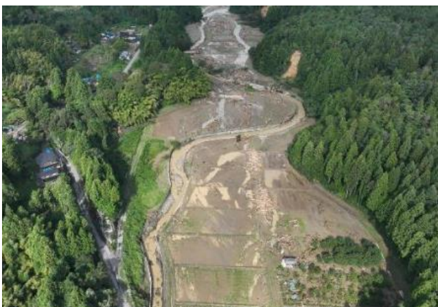
【豪雨】農地への土砂流入（珠洲市）
