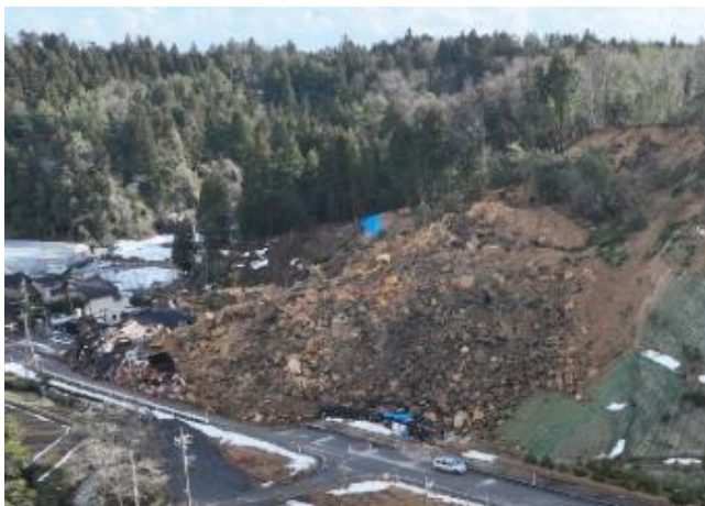
【地震】山腹崩壊（珠洲市）
