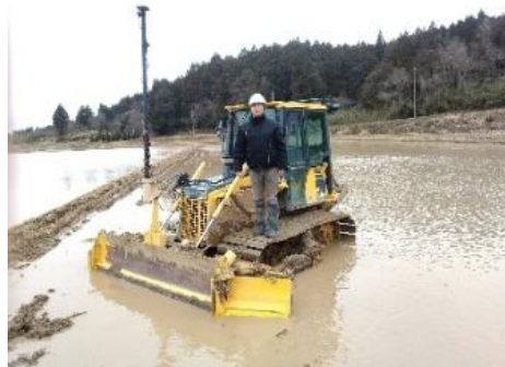
農業用ブルドーザを活用した 農地の自主復旧
