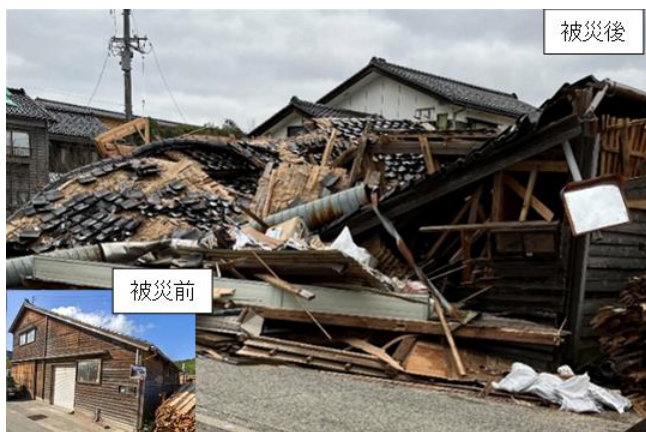
【地震】製材工場の損壊（輪島市）
