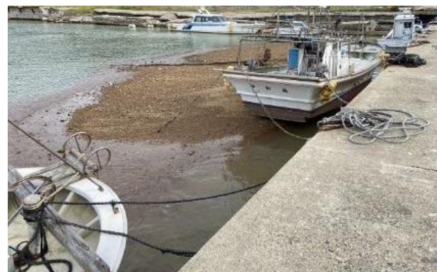
【豪雨】漁港内に土砂堆積（珠洲市）
