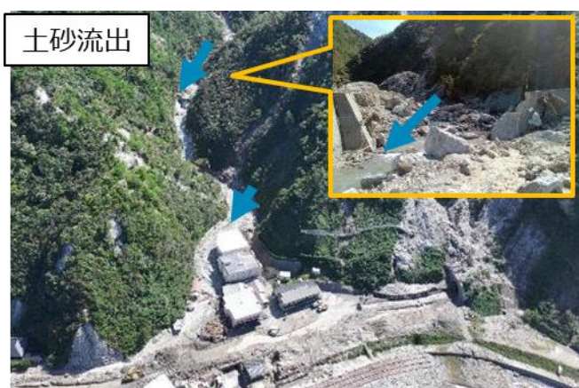
【豪雨】上流部からの土砂流入（珠洲市）
