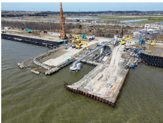
水管橋完成(R8.2時点)
