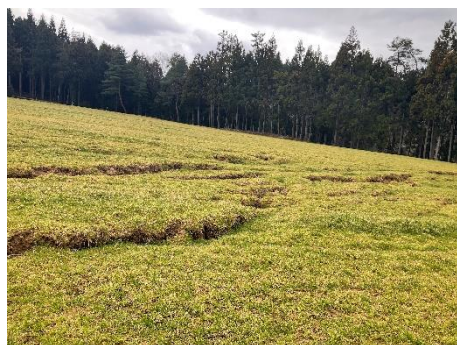
盛土の谷方向へのズレで発生した亀裂
