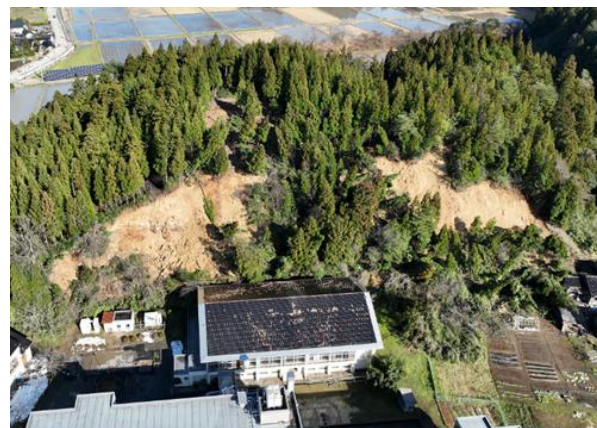
【地震】山腹崩壊（珠洲市）
