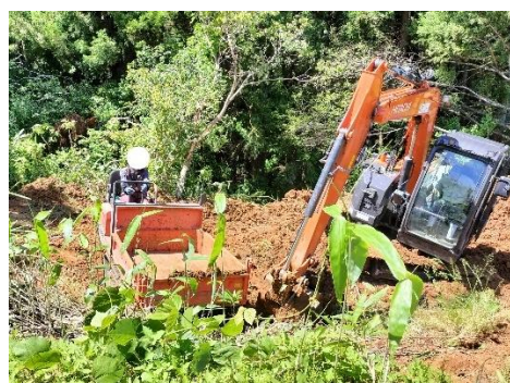
復旧状況①
