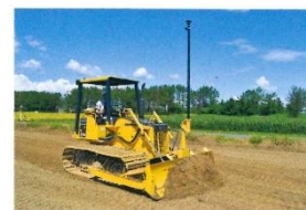
農業用ブルドーザによる均平作業
