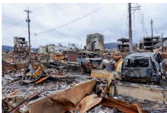
輪島市内の火災被害
