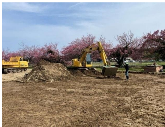
農地の土砂撤去（珠州市）
