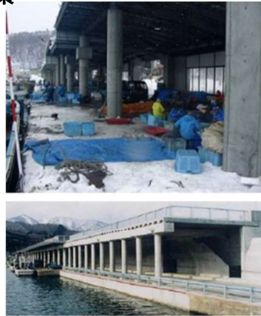
屋根付き岸壁（防風雪）
