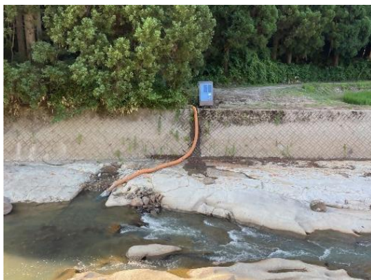
仮設ポンプの設置（能登町）
