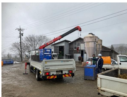
発電機の設置
