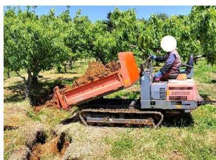
復旧状況②
