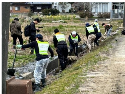
水路の泥上げ
