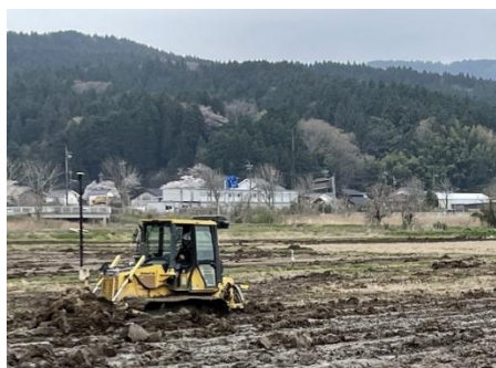
農家による直営施工実施状況
