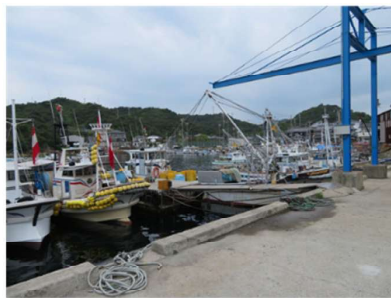
橋形クレーン
