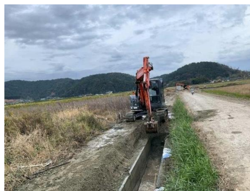
排水路の土砂撤去（輪島市）
