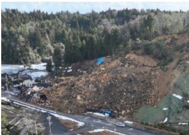
【地震】山腹崩壊（珠洲市）
