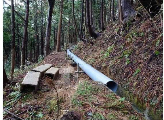
用水路の応急復旧状況
