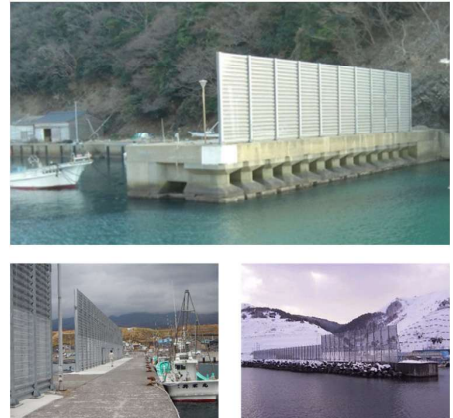
係留施設に設置した防風柵
