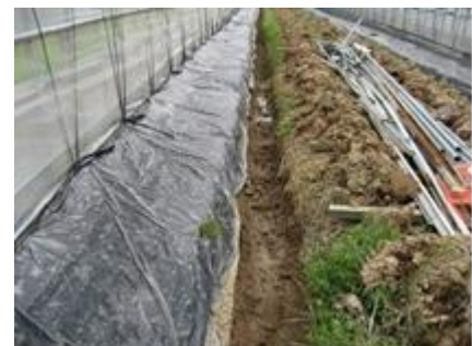
ハウス周辺の排水溝
