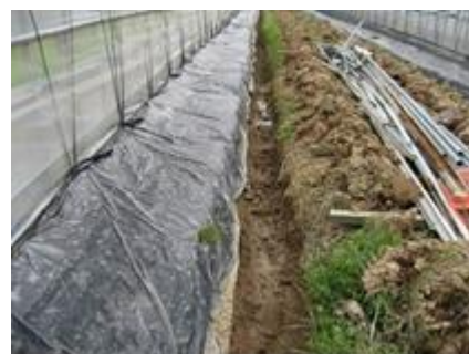
ハウス周辺の排水溝
