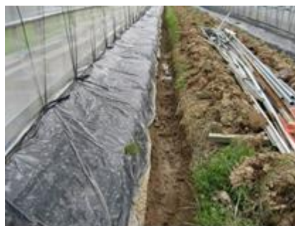
ハウス周辺の排水溝
