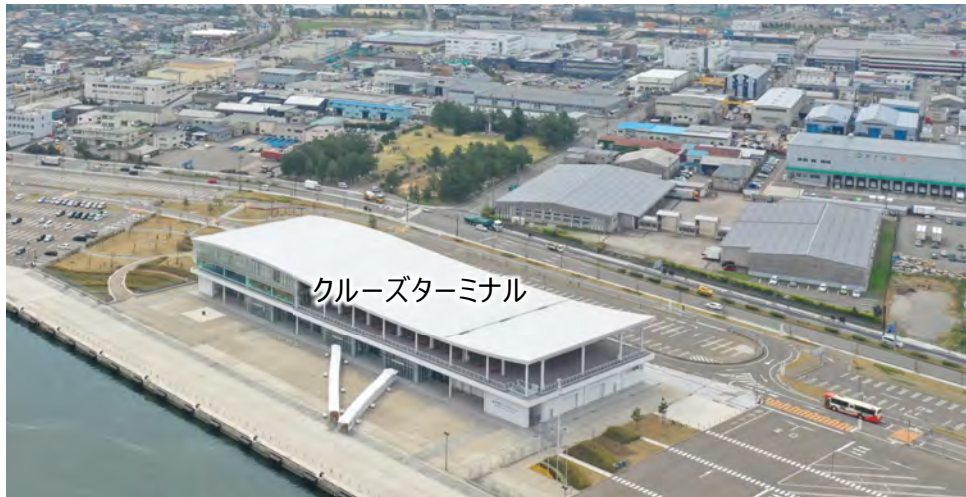
図 4-15 クルーズターミナル周辺の状況
