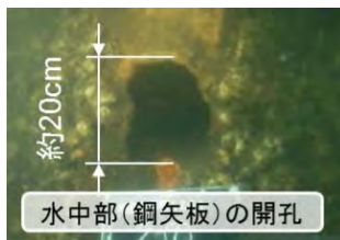
図 4-27 港湾施設の老朽化状況
