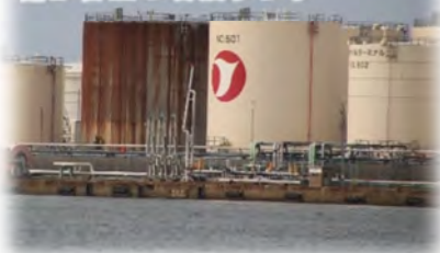
錆が目立つ石油タンク
