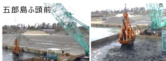
図 4-29 浚渫工事状況
