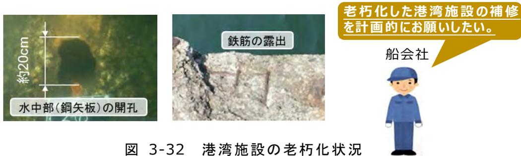
図 3-32 港湾施設の老朽化状況
