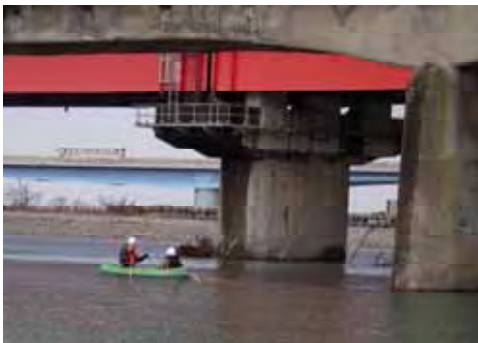
遠望目視による定期点検
