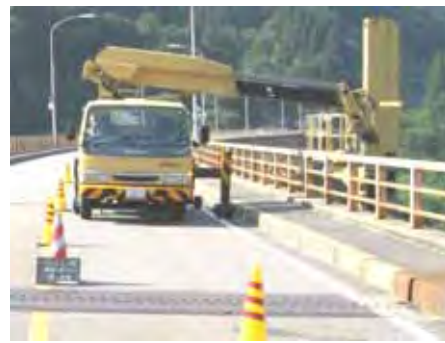
橋梁点検車による近接目視定期点検
