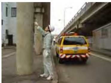
定期点検、道路パトロール
