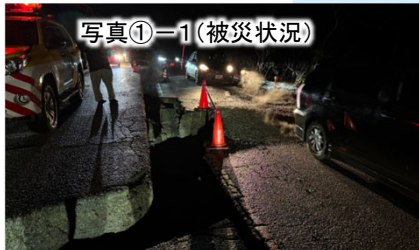
路面段差の解消により大型車の通行確保
