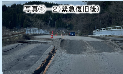
路面段差の解消により大型車の通行確保
