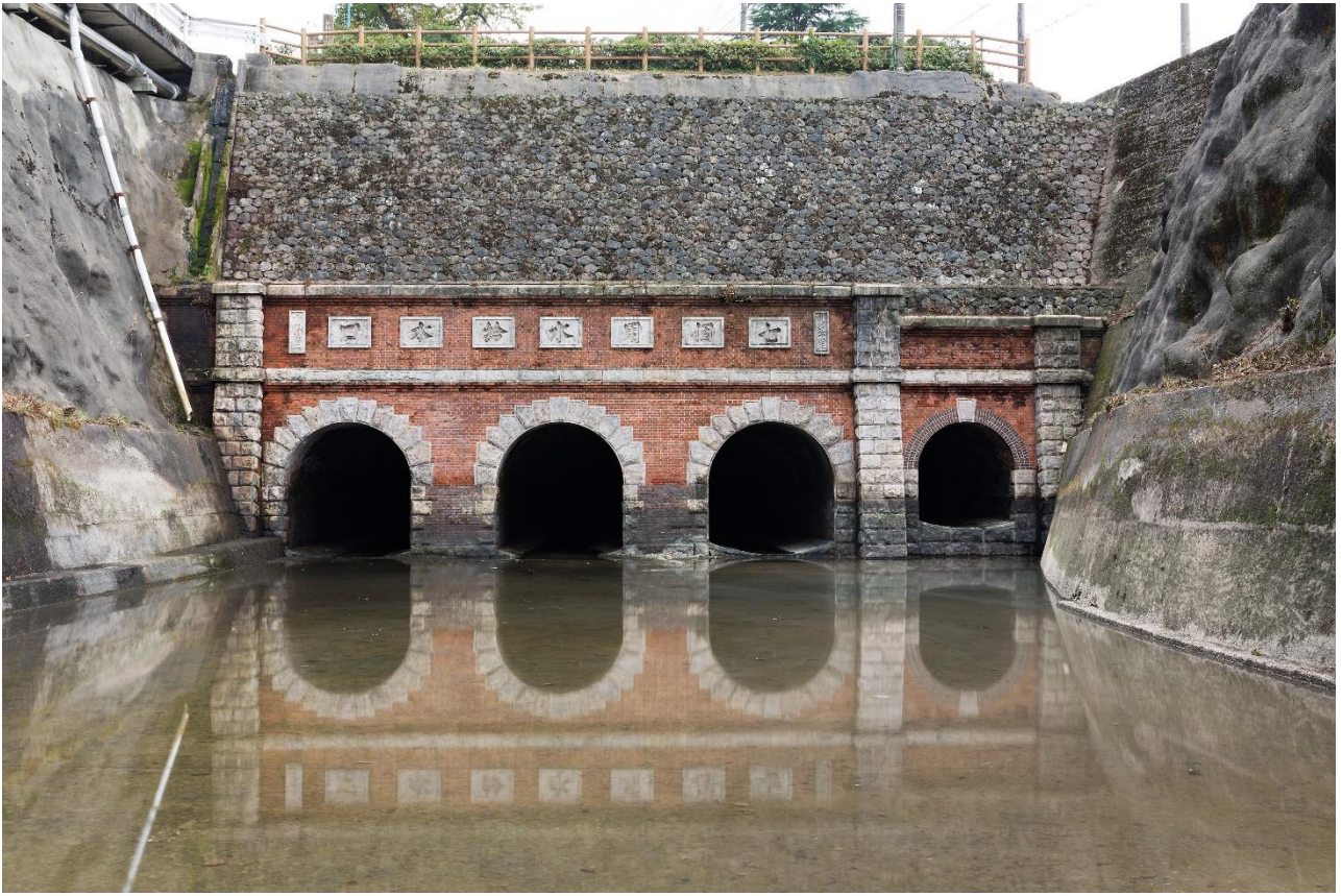
取入口隧道 出口
