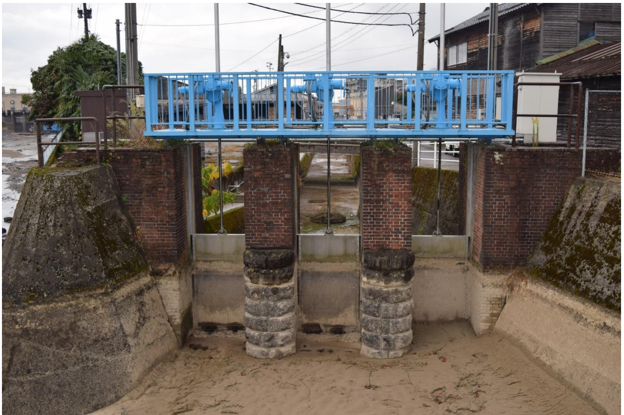
富樫用水取入口水門
