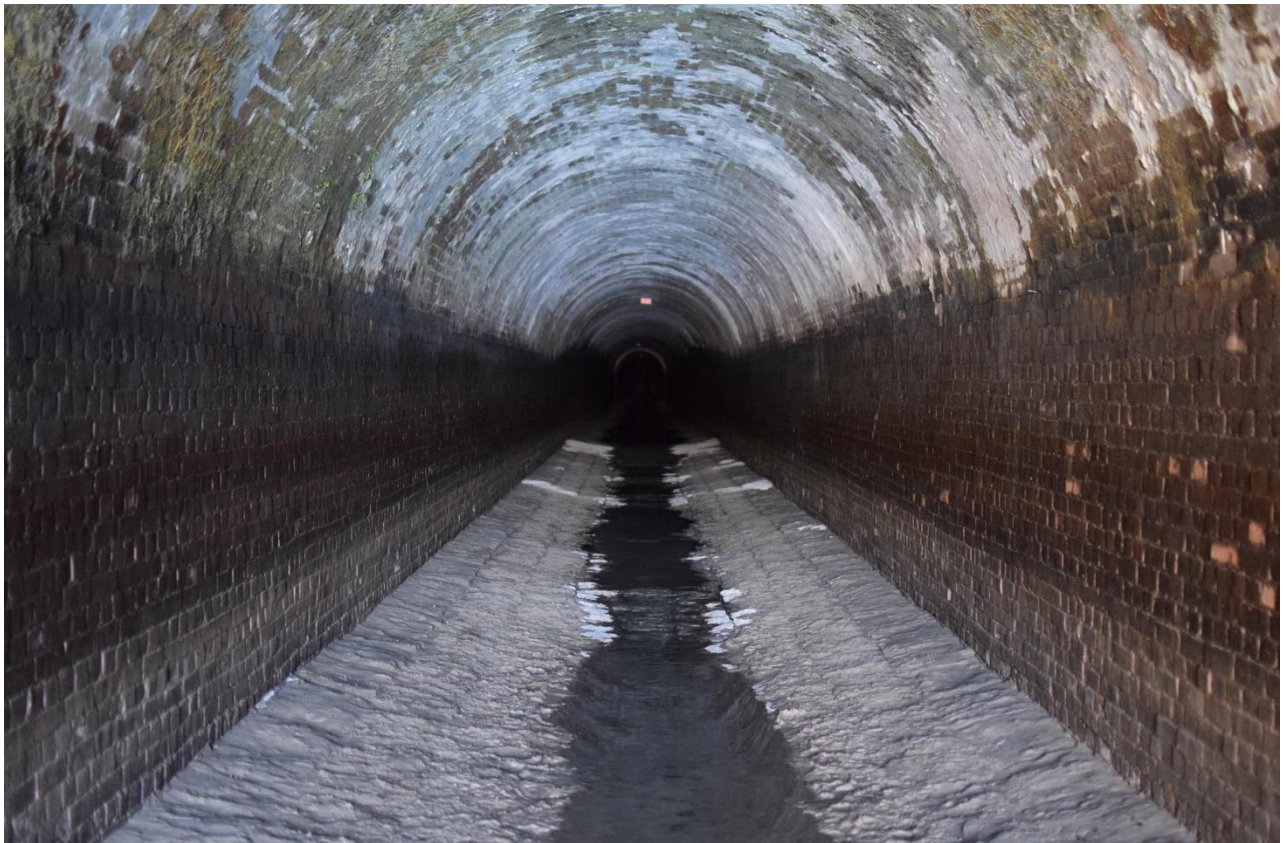
取入口隧道 水路中間部
