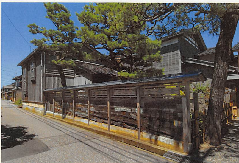
観田家住宅・主屋・西塀・西藏 (国登録有形文化財建造物)
