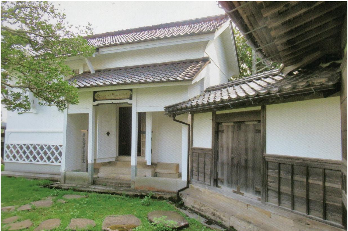
旧室木家住宅米蔵・中門
