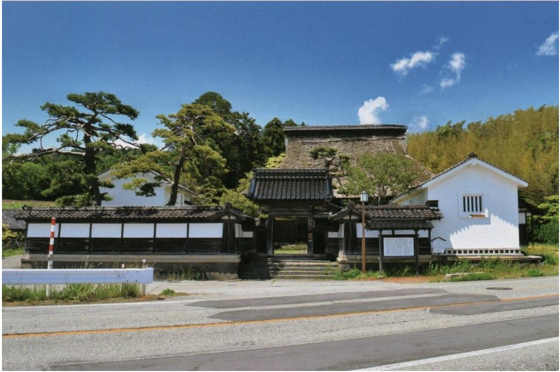
旧室木家住宅 全景
