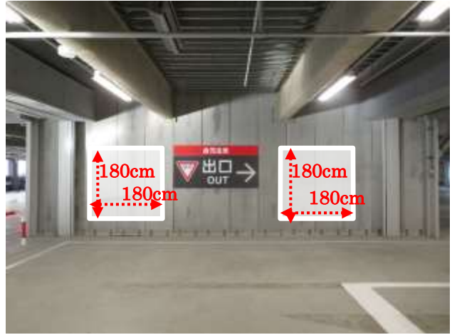
③ 3階から2階への下りスロープ出口正面
