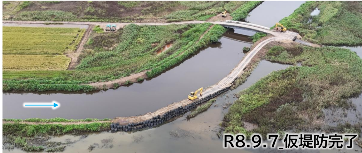
金丸川（羽咋市金丸出町）応急復旧完了
