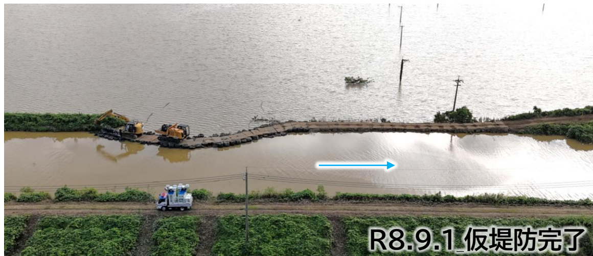
飯山川（羽咋市南潟町）応急復旧作業中
